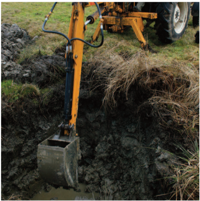
Fundamentierung unter Wasser
